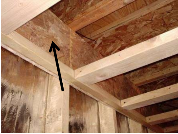
5. Madera contrachapada utilizada como bloqueo contra el fuego desde el soffito hasta las cavidades de la pared.
