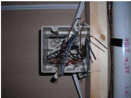
1. La instalación eléctrica tiene todas las cajas preparadas y listas con extremos de 6 pulgadas como mínimo.
