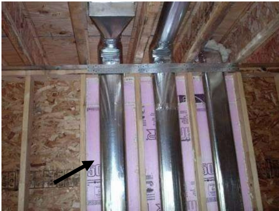
7. 1 ½ de aislamiento de espuma rígida utilizado detrás de los conductos de calor en las paredes exteriores
